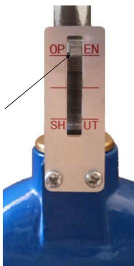
La norma UNI 10779 prevede che i gruppi attacco per autopompa di mandata siano dotati di valvola di intercettazione, **normalmente aperta**, conforme alla UNI 11443. Dotata pertanto di un sistema d'identificazione della stato di apertura/chiusura.
